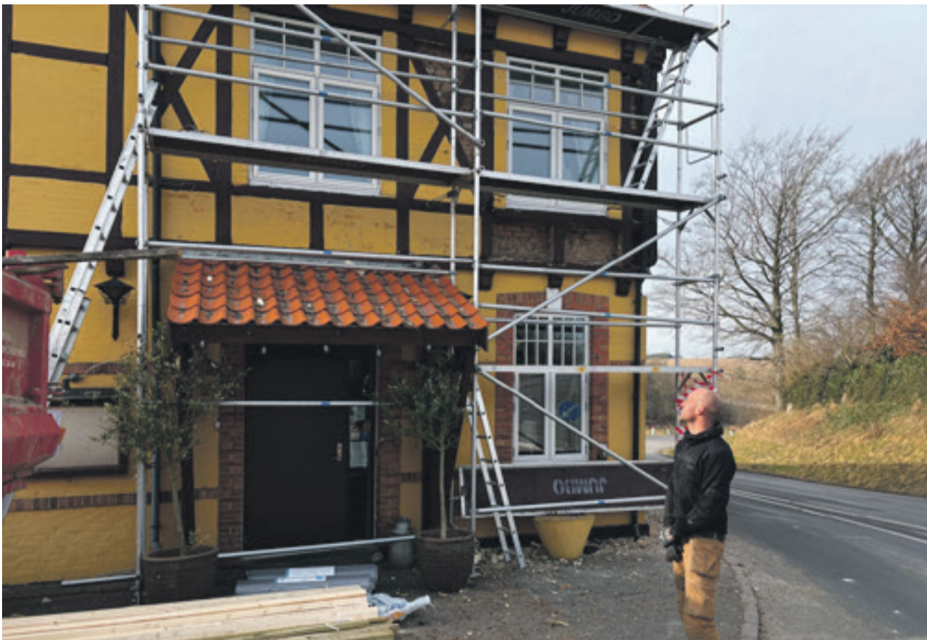
Halvanden time tog det for krofatter Rasmus at fjerne tagstenene over indgangspartiet. Her vurderer han bindingsværket, som også trængte voldsomt til en udskiftning. Foto: Kjeld Lundbæk
