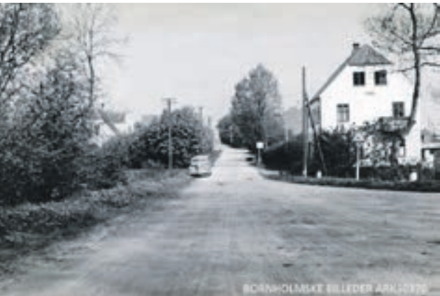
Foto fra maj måned 1946 taget af amtets tekniske forvaltning Da Røvej endnu var en grusvej. Foto: Bornholmske Billeder
